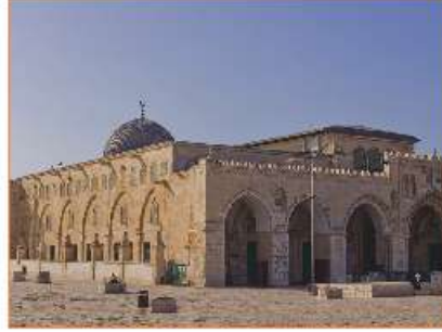
المسجد القبلي جزء من المسجد الأقصى / القدس
